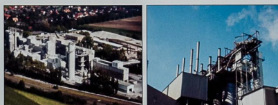
Abb. 8: Links: Blick auf das Kalkwerk Münchehof im Industriegebiet der Stadt Seesen. Hier erfolgt die höchstmögliche Veredelung des Rohmaterials vom Winterberg-Iberg durch Brennen, Mahlen und Hydratisieren. Rechts: Orlananlage des Kalkwerks zur Erzeugung von Branntkalk.
