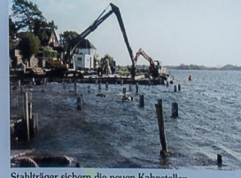
Stahlträger sichern die neuen Kahnstellen
