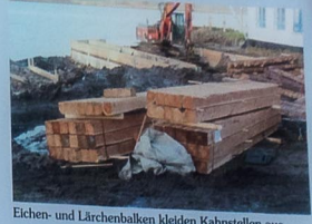
Eichen- und Lärchenbalken kleiden Kahnstellen aus
