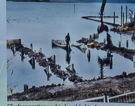
Glasfaserplatten verhindern künftig Ausspülungen
