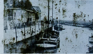
Der Hafen von Freiburg um 1933. Die hölzerne Uferwand ist durch eine eisernen Spundwand ersetzt, die Pfähle durch Eisenbohrschienen. (Archiv Schlichtmann)
